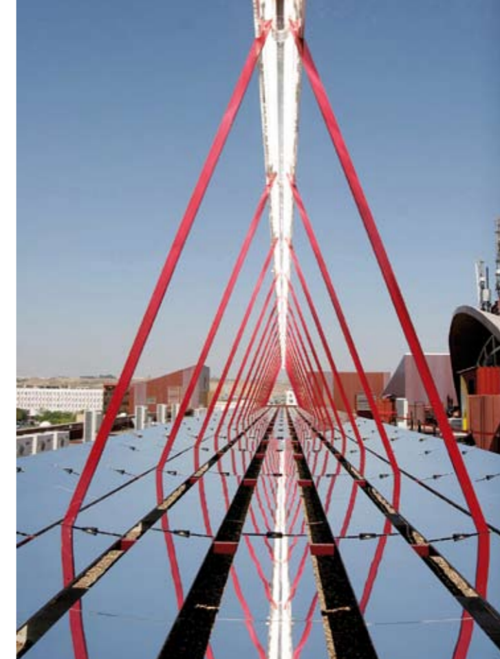
El captador solar Fresnel es capaz de calentar el fluido caloportador hasta 195° C.
